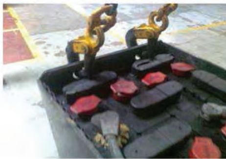
Manipulación de baterías con aparatos elevación
