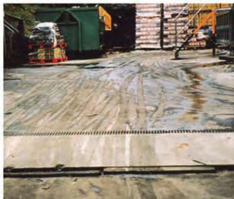
Zonas de paso de carretillas elevadoras con riesgo por acumulación de materiales y ausencia de fijación de las protecciones en el suelo
