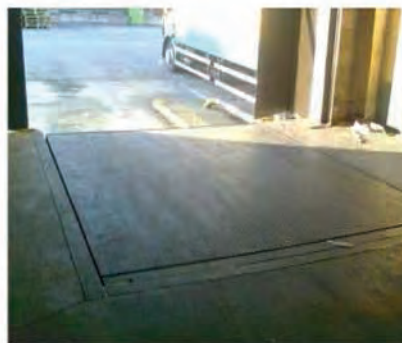
Sin delimitación de rampa de carga
