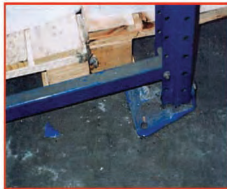
Estantería sin anclaje adecuado (estos deben instalarse según las instrucciones de montaje)
