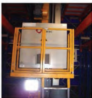
Puesto de operador de transelevador
