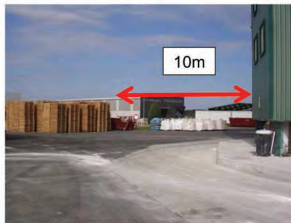
Separación entre paletas y edificación
