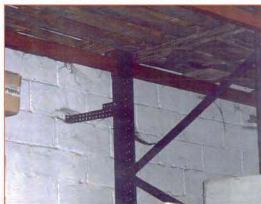
Arriostamiento de la estantería a pared
