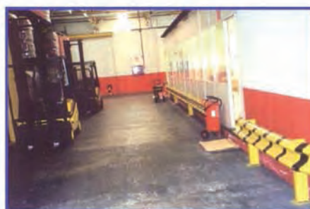
Instalar una protección mecánica frente a golpes en tabiques acristalados es una buena práctica de prevención
