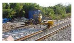
Máquina estática, no propulsada cuya función principal consiste en la manipulación del carril una vez descargado con el objetivo de situarlo en su posición definitiva sobre la traviesa.
