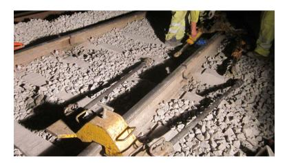
Equipo neumático dotado de gatos de tracción que es utilizado para la operación de liberación de tensiones en tramos de vía una vez obtenida la barra larga soldada y previamente al afloje del tramo de carril.
