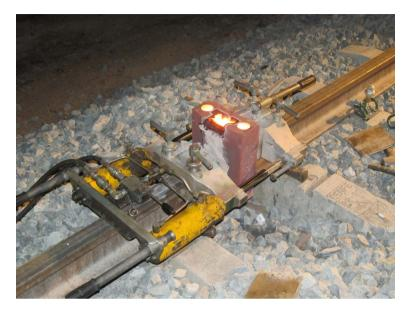
Equipo de corte que a modo de cizalla elimina el exceso de material una vez finalizada la soldadura aluminotérmica entre dos carriles.
