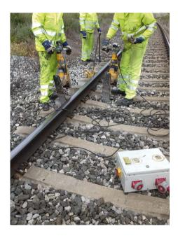
Equipo manual de bateo destinado a la compactación de balasto mediante el clavado y vibración del bate en la zona de trabajo estando sujetado por el personal.
