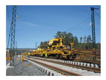
Conjunto formado por locomotora y plataformas de carga destinado al transporte y tendido de carril desde la vía de trabajo a la plataforma. Existen modelos de descarga lateral y trasera.
