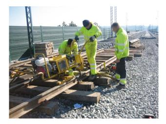
Equipo giratorio destinado al apriete y aflojado de tirafondos de fijación de carril y traviesa. Dispone de una carcasa con ruedas que le permite deslizar sobre la vía mediante el empuje manual del personal.
