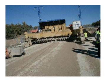
Máquina autopropulsada dotada de elementos de extendido de balasto que se desplaza por la plataforma de la infraestructura para conformar la base de la superestructura de la vía.
