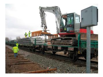
Conjunto formado por locomotora y plataformas de carga destinado al transporte, carga y descarga de traviesas y/o conjuntos (parejas carril/traviesa).
