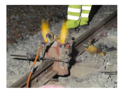
Equipo generador de llama dotado de botellas de gas licuado y soplete específico destinado a alcanzar una temperatura óptima en el carril previamente a su soldadura.
